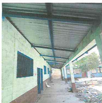
Foto 3: MANTENIMIENTO A PUERTAS Y ESTRUCTURA CAMBIO DE CHAPA A PUERTAS
