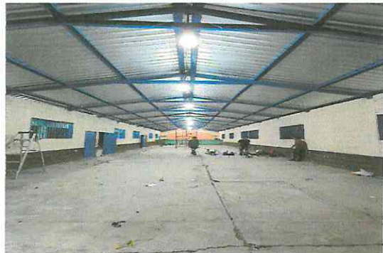
Foto1: CAMBIO DE CUBIERTA DE LAMINA AL SALON DE USOS MULTIPLES
