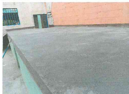
Foto 2: REPARACION DE LOSA DE ESENARIO
